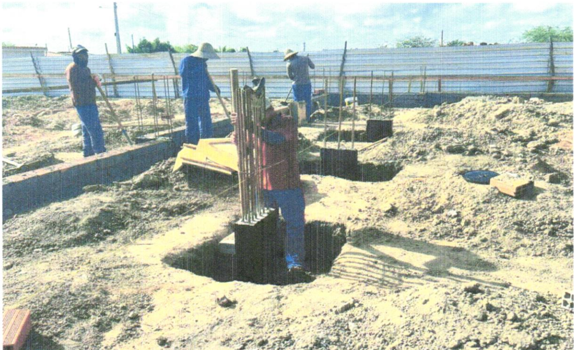
FOTO 12 – Regularização e compactação do fundo de valas
