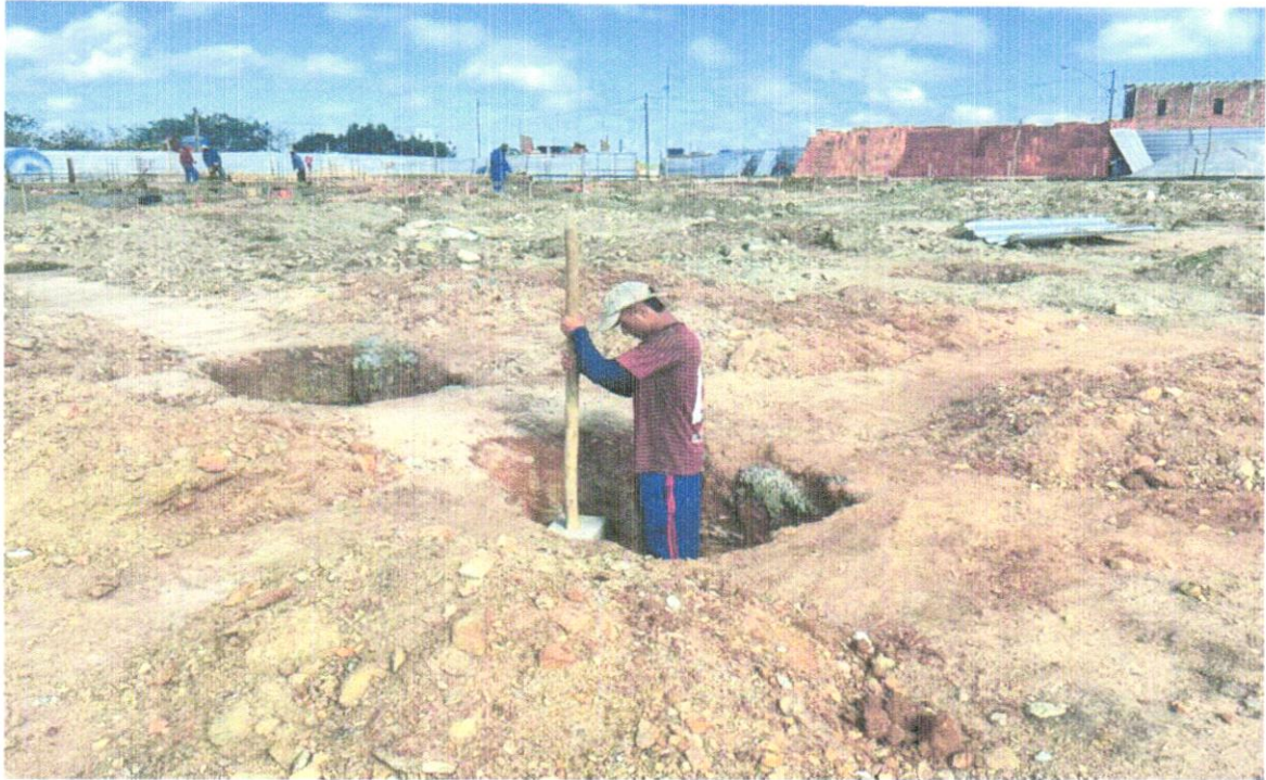
FOTO 12 – Regularização e compactação do fundo de valas
