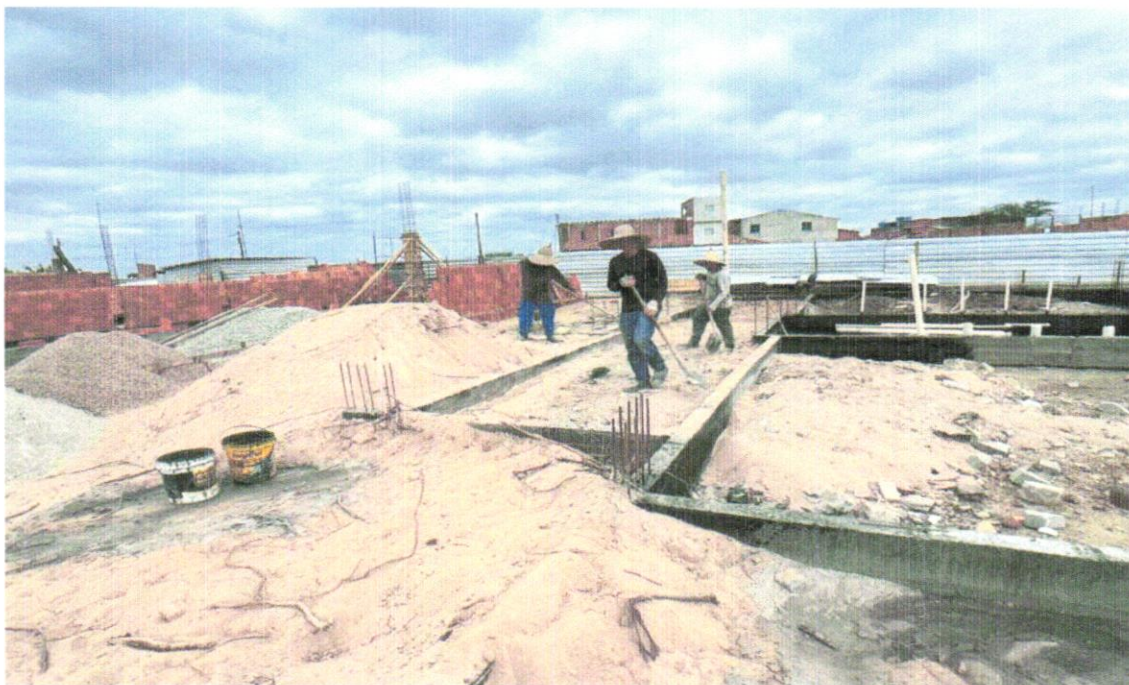
FOTO 62 – ATERRO MANUAL DE VALAS COM SOLO ARGILO-ARENOSO E COMPACTAÇÃO MECANIZADA. AF_05/2016
