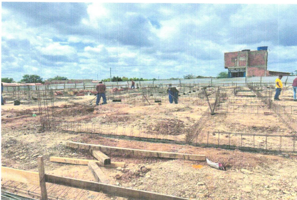
FOTO 10 – Regularização e compactação do fundo de valas
