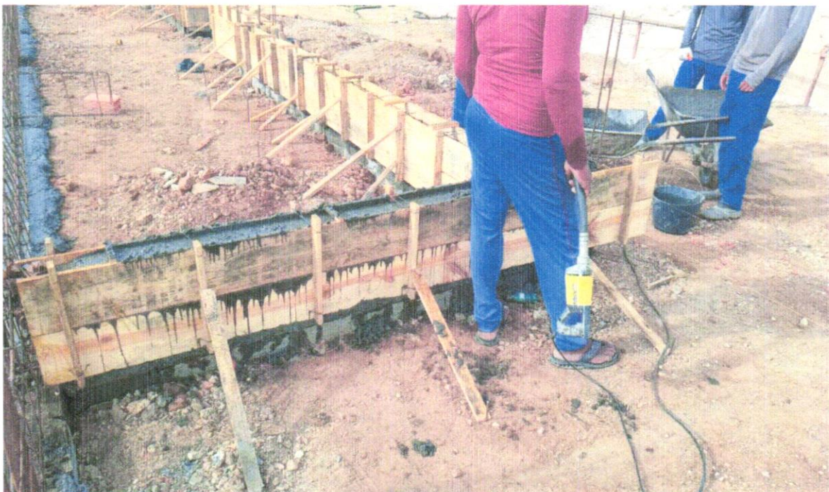
FOTO 40 – Concreto Bombeado fck= 25MPa; incluindo preparo, lançamento e adensamento
