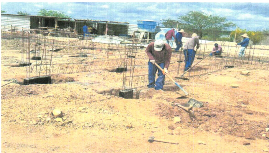
FOTO 08 – ATERRO MANUAL DE VALAS COM SOLO ARGILO-ARENOSO E COMPACTAÇÃO MECANIZADA. AF_05/2016
