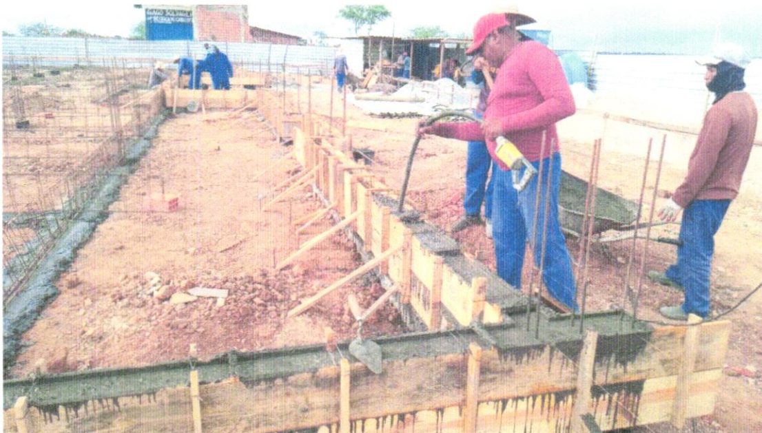
FOTO 38 – Concreto Bombeado fck= 25MPa; incluindo preparo, lançamento e adensamento
