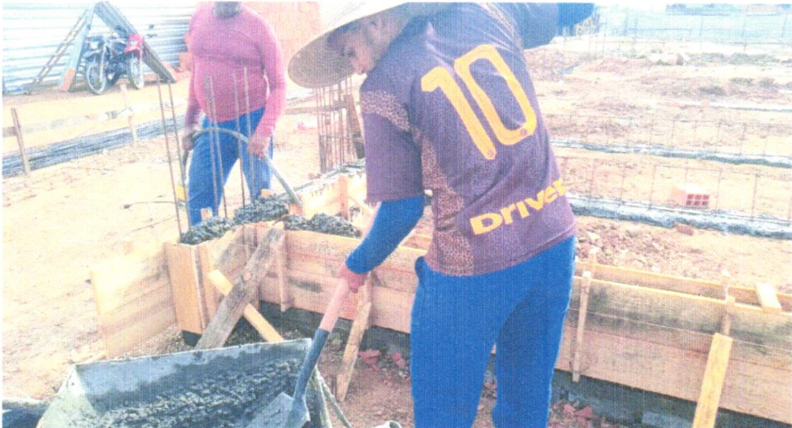
FOTO 40 – Concreto Bombeado fck= 25MPa; incluindo preparo, lançamento e adensamento
