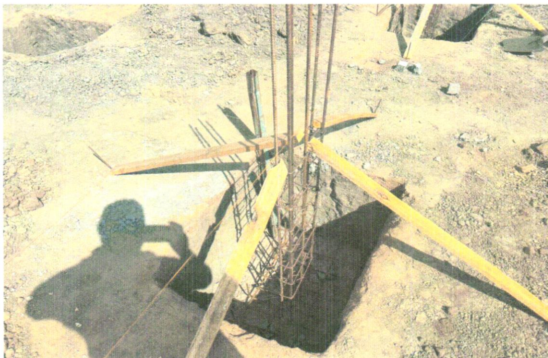
FOTO 20 – Armação de aço CA-50 Ø 8mm; incluso fornecimento, corte, dobra e colocação
