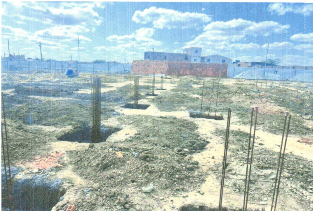
FOTO 20 – Armação de aço CA-50 Ø 8mm; incluso fornecimento, corte, dobra e colocação
