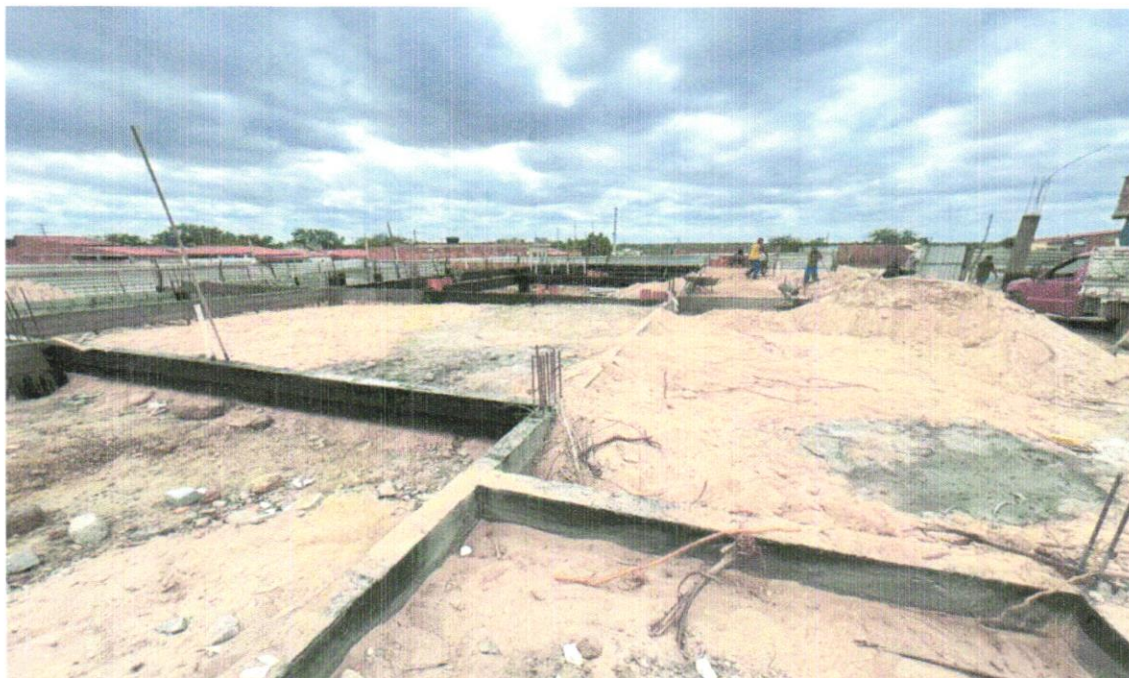
FOTO 62 – ATERRO MANUAL DE VALAS COM SOLO ARGILO-ARENOSO E COMPACTAÇÃO MECANIZADA. AF_05/2016
